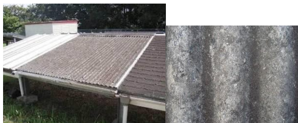
写真6 スレート小波板
