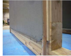
写真-5 左官工事(直交壁無)
