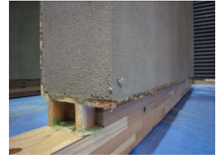
写真-6 左官工事(直交壁有)
