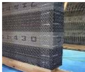
写真-2 下地造作(ラス工事)
