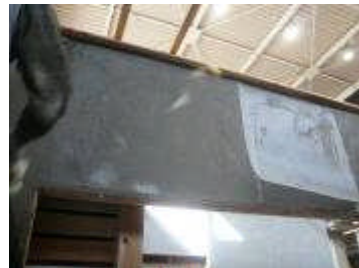
写真-9 ネット伏せこみ (伏せこみ終わり)
