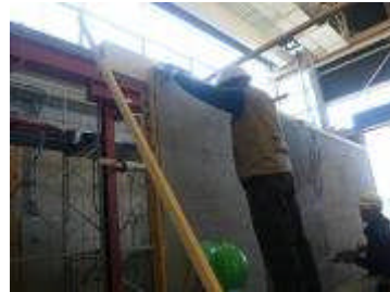
写真-7 モルタル塗付け (上塗り)、ネット伏せこみ
