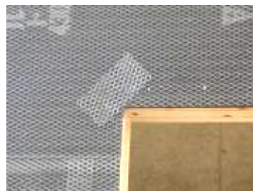
写真-4 ラス張付け (開口補強)
