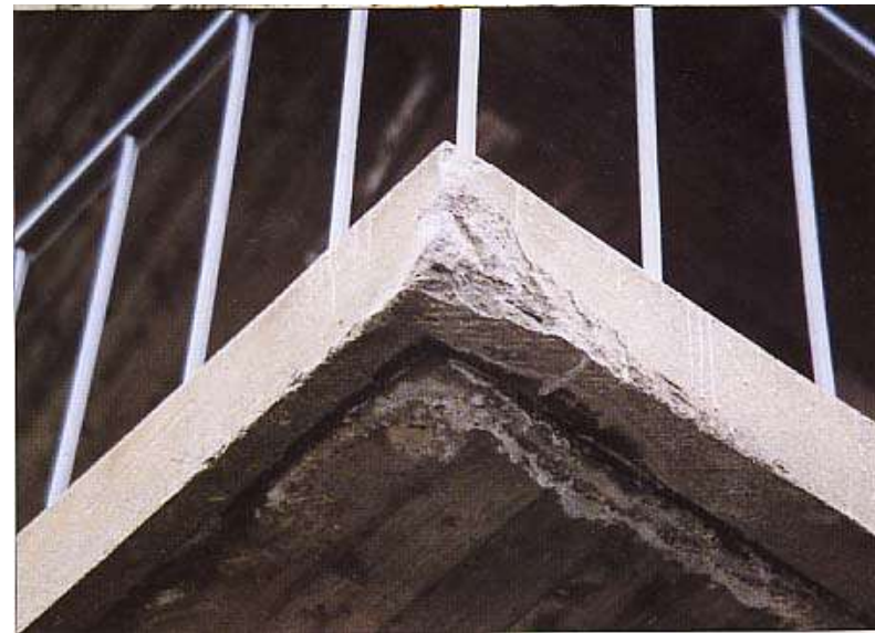
塗膜保護のないコンクリート の滑落事例
