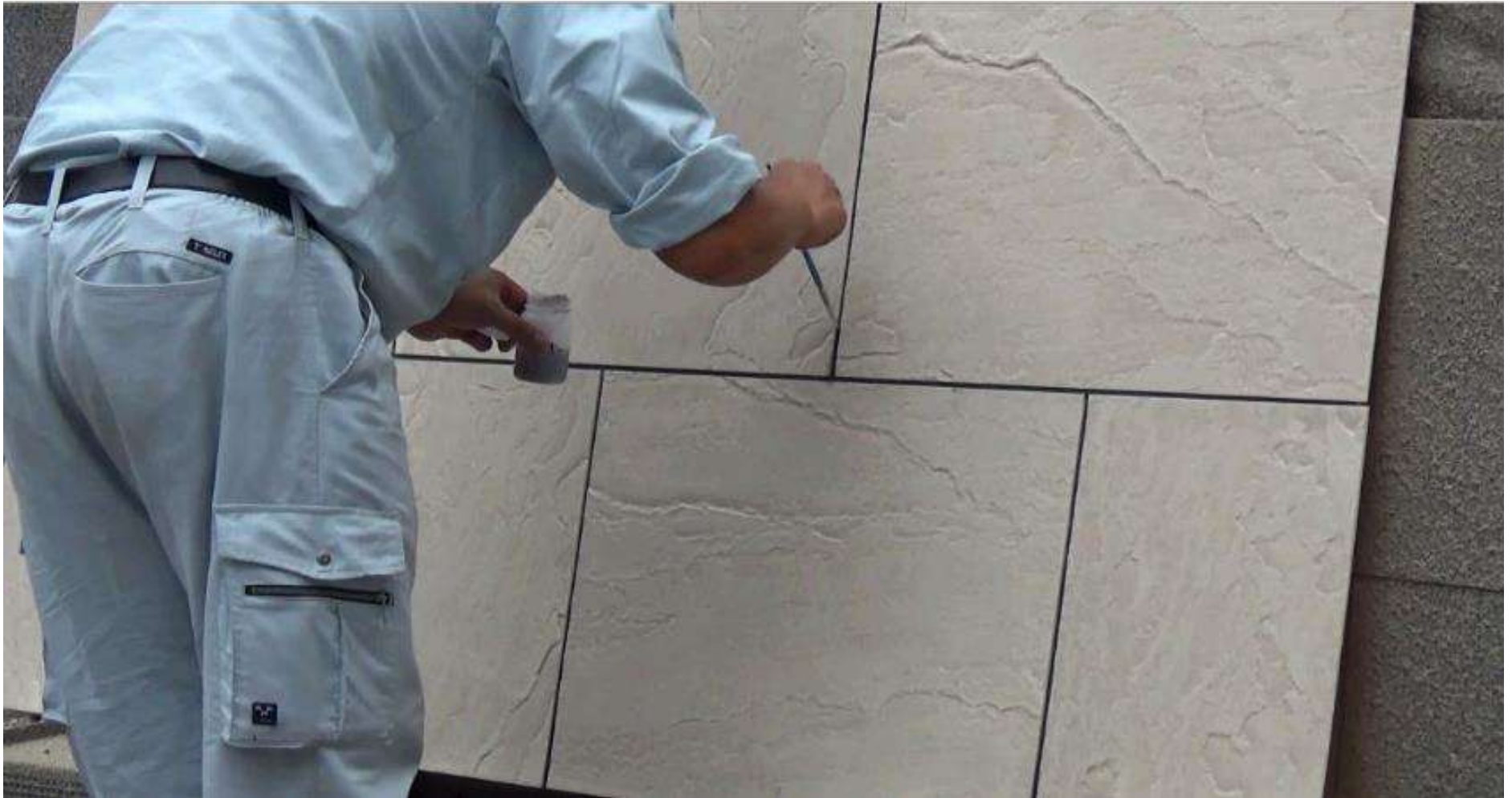
目地処理の様子:(目地処理を行っている)
