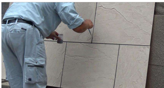
目地処理の様子:(目地処理を行っている)
