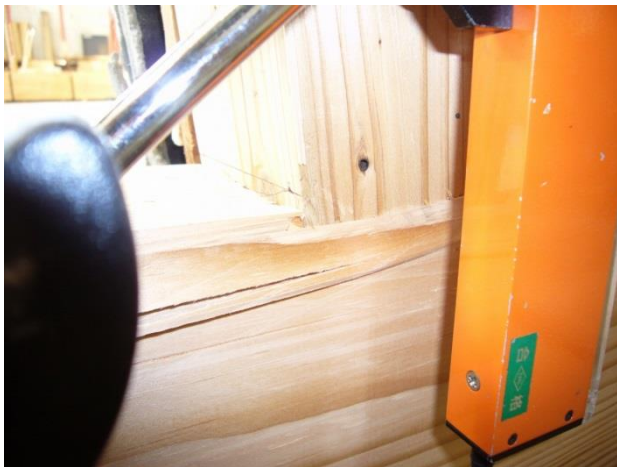
写真 3.2.30 No.3-a4 柱脚圧壊
