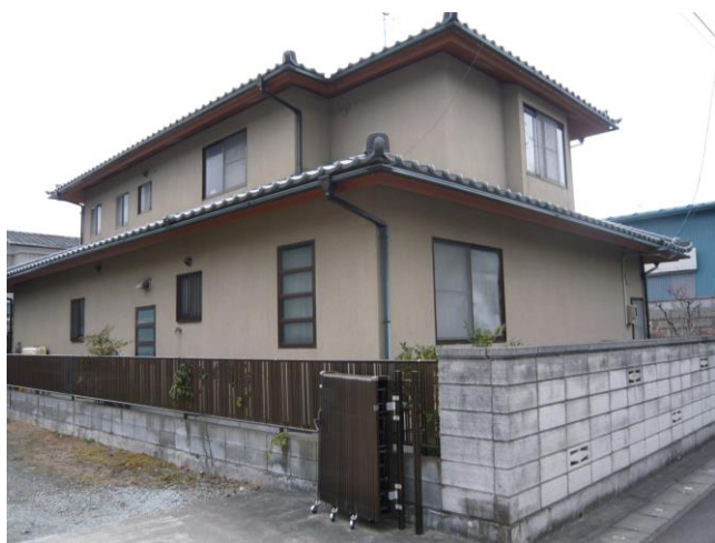
写真 2.1.19 損傷が認められなかったラスモルタル外壁の例(名取市)ひび割れ無
