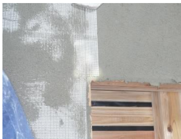
写真 3.2.9 ネット伏せこみ(伏せこみ始め)
