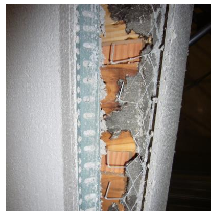
写真 3.3.27 コーナー部の破断
