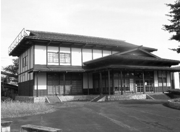
写真 2.1.7 ラスモルタル外壁の建物
