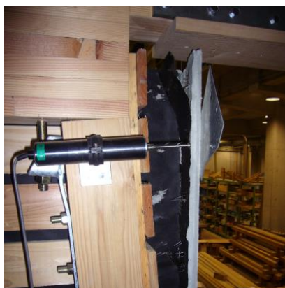
写真 3.3.26 モルタルの剥離
