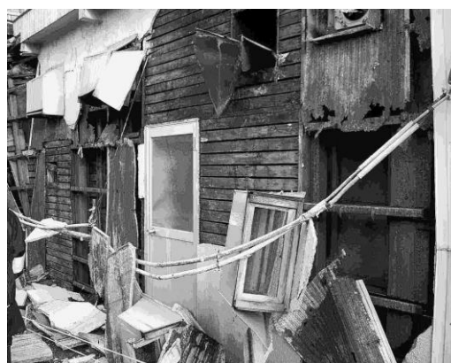
写真 2.1.4 下地の腐食
