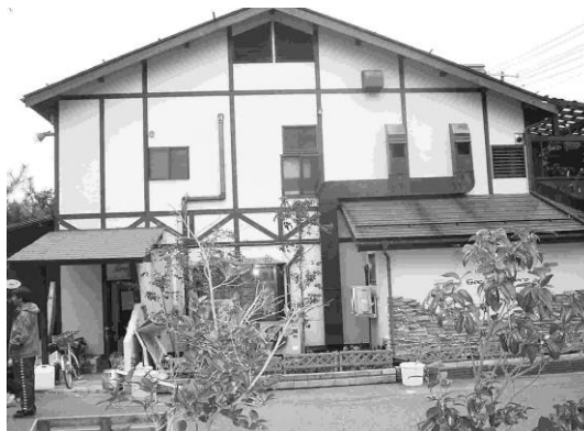
写真 2.1.6 ラスモルタル外壁の建物
