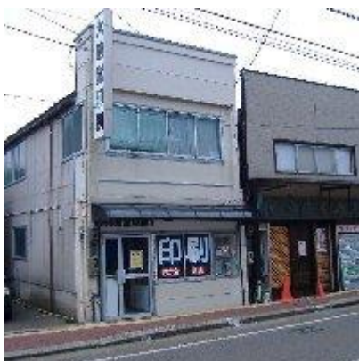
写真 2.1.14 店舗併用住宅(東本町) 築 30 年以上玄関周りのみラスモルタル外壁
