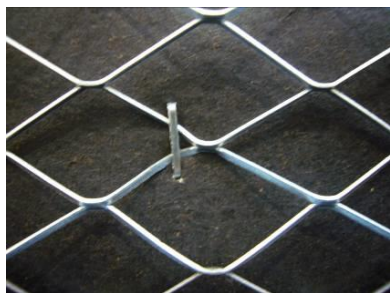
写真 3.3.11 ラス横張りのステープル
