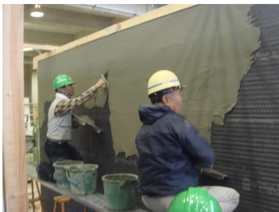
写真 3.2.7 モルタル塗付け(下塗り)
