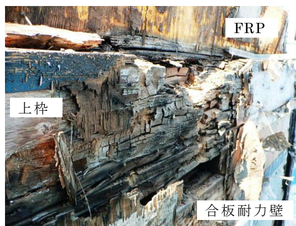
写真 4.3.2 外装除去後のバルコニー外壁(築 5 年)
