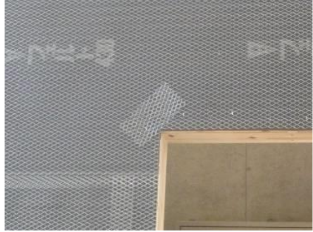
写真 3.2.5 ラス張付け(開口補強)
