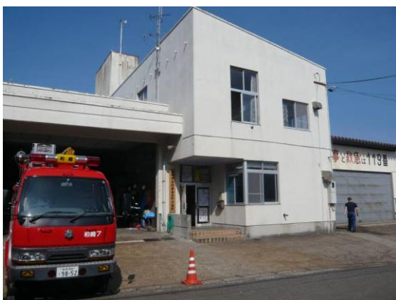
写真 2.1.12 鉄骨造ラスモルタル外壁
