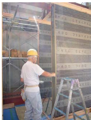
写真 3.3.14 下塗り施工
