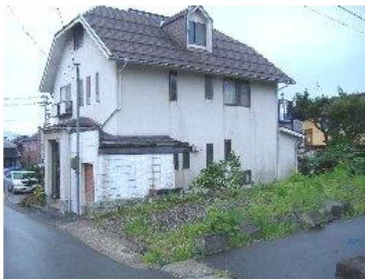
写真 2.1.15 ラスモルタル外壁建物(築約 20 年)
