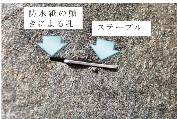
写真 4.2.2 防水紙の寸法変化による孔
