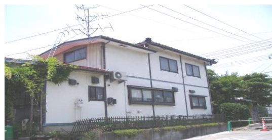
写真 2.1.13 ラスモルタル真壁外壁(築約 20 年)外部柱を銅板で覆うことで腐朽を防止し、構面内にモルタル壁を設置することで耐震性を考慮した建物
