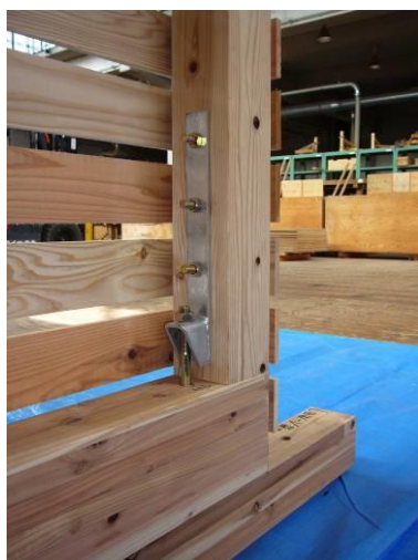
写真 3.3.4 ホールダウン金物 写真 3.3.5 構造用合板下地 写真 3.3.6 構造用合板縦張り
