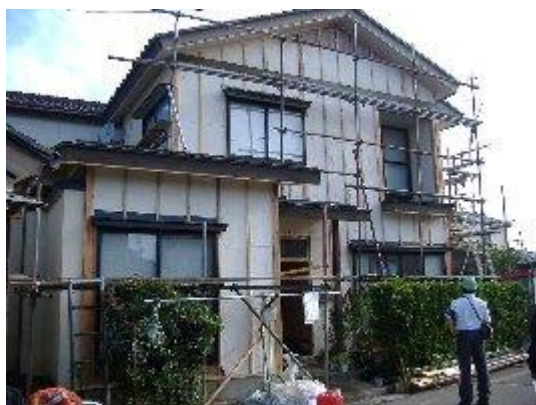
写真 2.1.17 改修中※のラスモルタル外壁建物(西本町) 築 30 年以上
