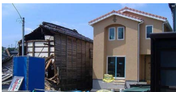
写真 2.1.16 新築中のラスモルタル外壁建物(西本町)
