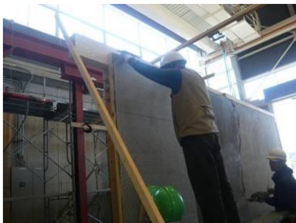
写真 3.2.8 モルタル塗付け(上塗り)ネット伏せこみ
