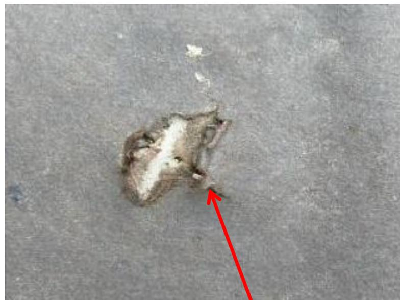
線径の細いラスの破断により脱落
