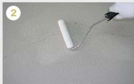
2 ウールローラーにてYGプライマーを塗布する
