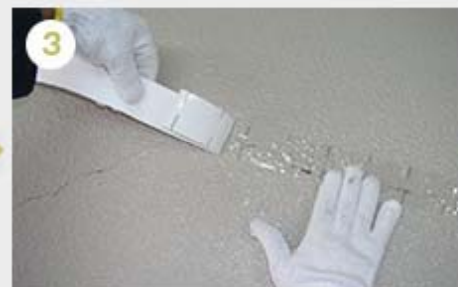
3 YGプライマー乾燥後離型紙を剥がしながらクラックがテープ内に納まる様貼って行く
