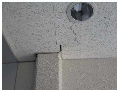
天井の吸音板
