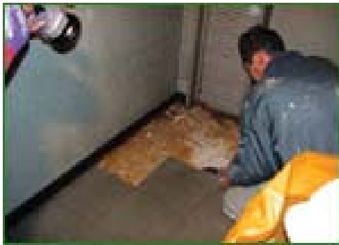
内部床のPタイル
