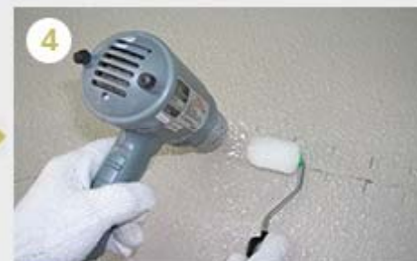
4 ヒーティングガンを用い、熱風をYGテープに当てて柔軟にし直ちに専用ローラーで、前後左右に転がし既存の柄(テクスチャー)に馴染ませて貼り付ける
