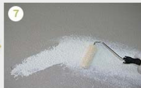
7 YGコートを砂骨ローラーでYGテープの上から塗布し始め、YGテープ上を厚めに塗布し外側に行くに従って徐々に塗厚を少なくして行く
