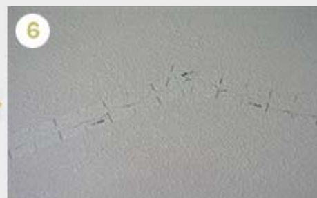
6 YGテープ貼り終わり状況 YGテープの特徴 YGテープは初期接着力は弱めに設定してあります。その理由は、接着力が高すぎると凸部に強く接着し、ローラーで押さえ込んでも凹部にテープが引っ張られない為、うまく馴染ませることが出来ません。 したがって、YGテープに熱風を当てて柔軟にし、直ちに専用ローラーで前後左右に転がし、既存の柄(テクスチャー)に馴染ませて貼り付けることが出来るのです。 その後、YGテープの粘着層が24時間経過後、時間を増すごとに粘着力が非常に強くなり2-3日後には十分な粘着力が得られます。以上がYGテープの特徴となります。
