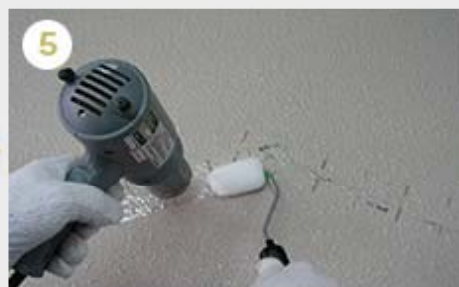
5 YGテープの貼付方向が変わる場合YGテープを1度カットして重ね貼りする。 (この時、重ね合うテープ部分へのプライマーは塗布しなくても良い) 後は、④と同じ要領で貼り付ける
