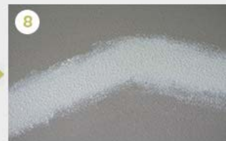
8 YGコートを砂骨ローラーで綺麗に塗布して完了 ここまでで、クラック処理TNC工法は完了です。(③~⑧までの工程は必ず当日施工として下さい。)
